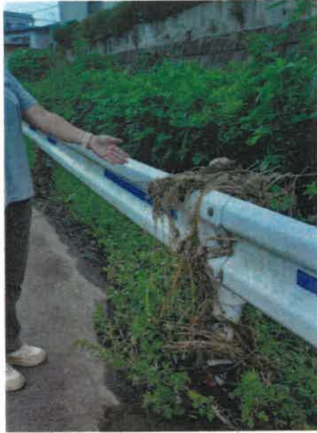
写真上＝住宅前の道路が膝まで冠水したことを示す住民（東町） 写真左＝ガードレールを越える越水の痕跡（岩曾町）
