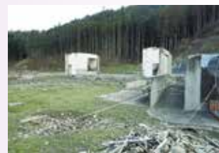
石巻市立大川小学校体育館跡
