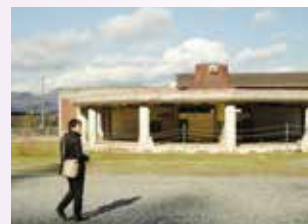
石巻市立大川小学校校舎跡
