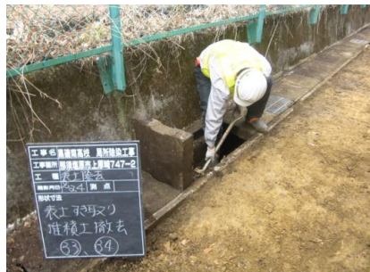
側溝等の除染
