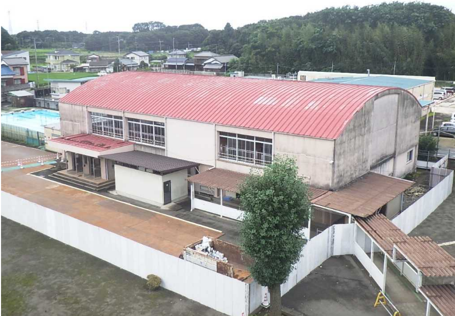
改修前 外観(東面)
