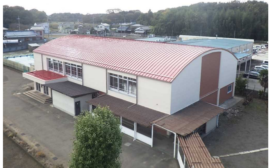
改修後 外観(東面)
