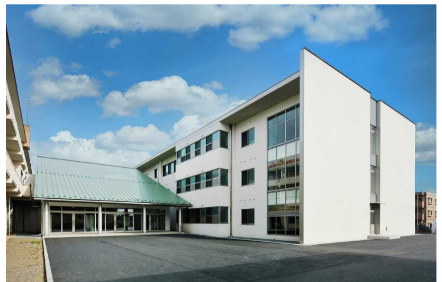
普通教室棟・昇降口棟
