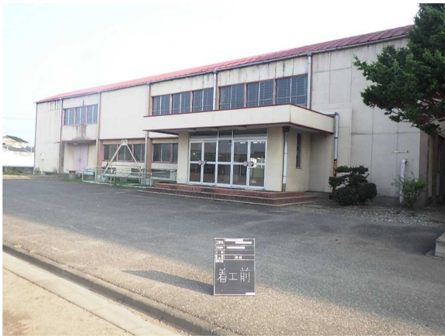
改修前 外観（南面）
