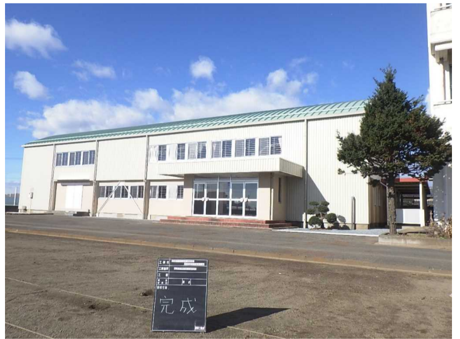
改修後 外観（南面）
