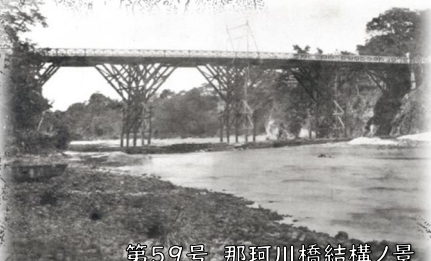
第59号 那珂川橋結構ノ景
