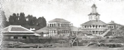
第11号 県庁建築ヲ斜面ニ見タル景
