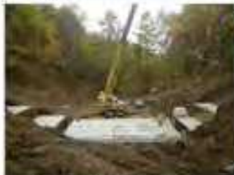
船ヶ沢川西側砂防堰堤の施工状況
