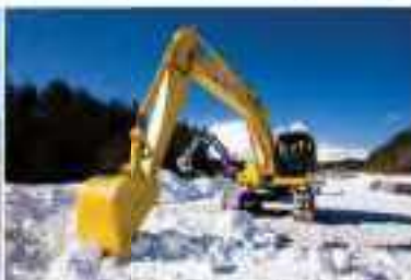
無人化施工による堰脚試験
