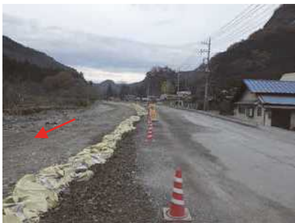
仮設道路設置状況
