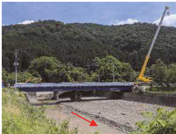
仮橋設置状況
