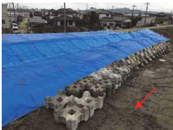
根固ブロック設置状況 (一級河川秋山川 佐野市赤坂町)
