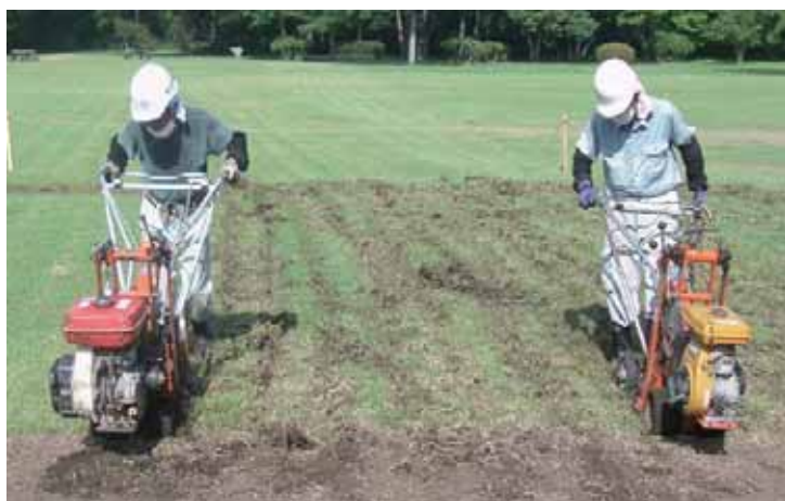
【除染作業の様子】
