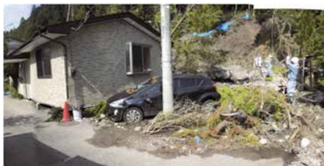
被災状況（日光市所野 広久保 I B）
