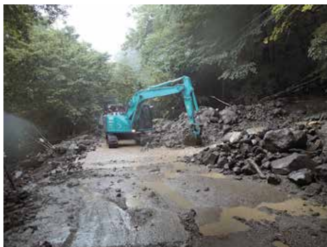
日塩有料道路 復旧作業状況
