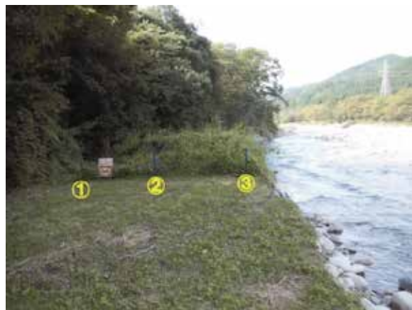
【流出箇所（被災後）】
