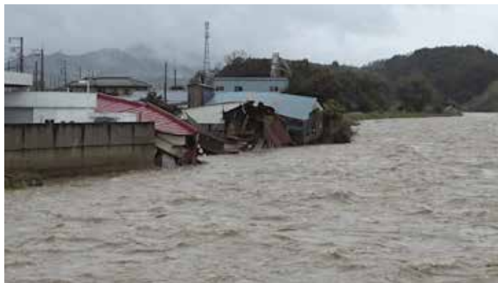
(鹿沼市内の工場損壊被害)
