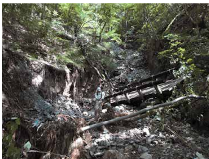
日光市鬼怒川鶏頂山線歩道（竜王峡歩道）木橋
