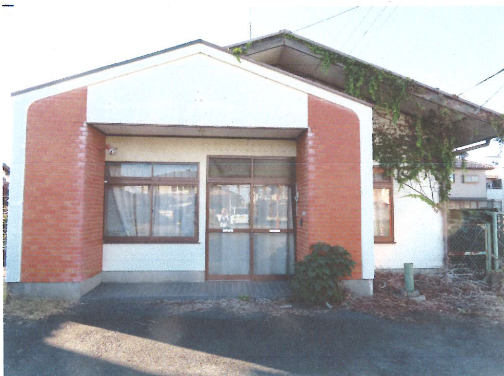
対象物件の東側から西方を見て撮影
