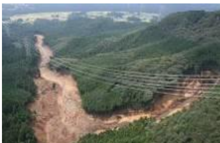
【平成27年9月豪雨災害による山地崩壊】
