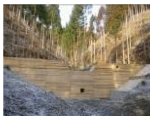
【復旧工事後の災害現場】
