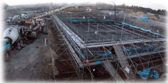
配水池築造の様子（S56）
