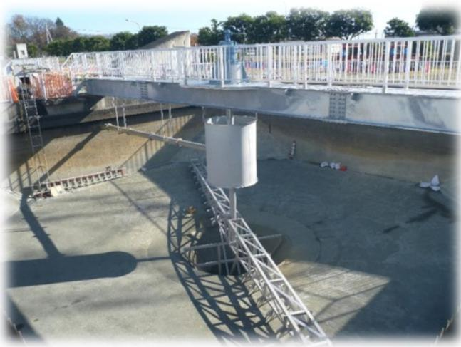
写真は更新中の濃縮槽の掻寄機です。中心から円周上に伸びるアームを回転させることで底に沈澱した汚泥を中心に収集します。通常は汚泥を貯留しています。
