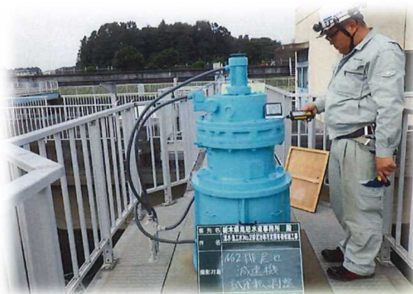
振動測定の様子 （濃縮槽汚泥掻寄機駆動部）
