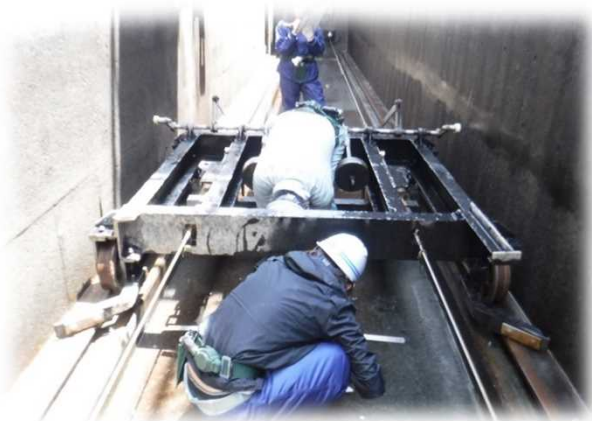
職員による年次点検1 （薬品沈澱池汚泥掻寄機）
