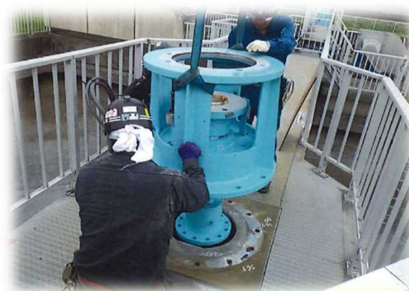
減速機取付の様子 （濃縮槽汚泥掻寄機駆動部）
