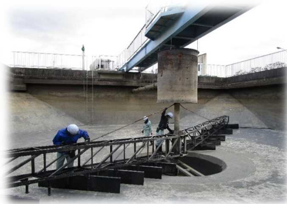
職員による年次点検2 （濃縮槽汚泥掻寄機）
