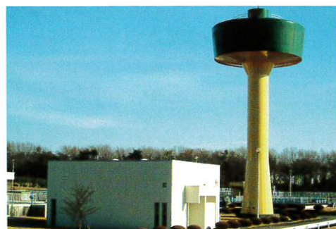
◇高架水槽・塩素混和池
