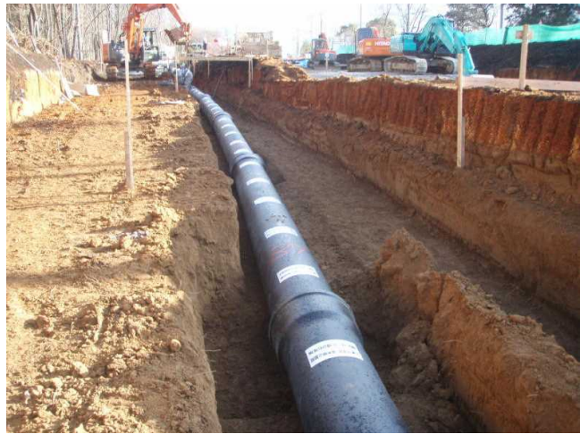
国道拡張工事に伴う配水管の布設替え(耐震管使用)
