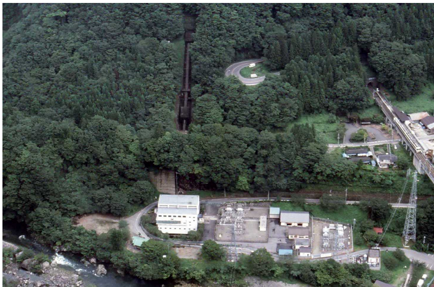
運転開始から60年を迎える川治第一発電所
