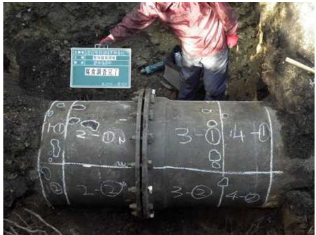
埋設管路の劣化診断調査
