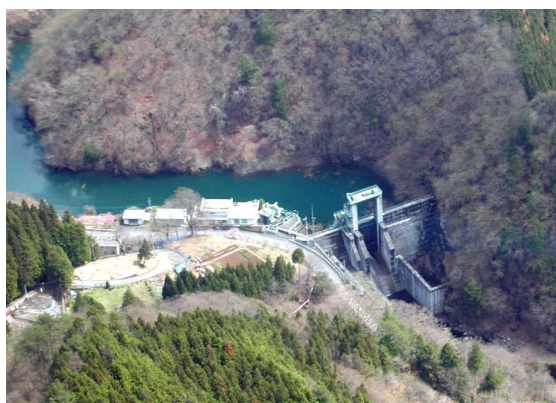
足尾発電所の取水ダムである庚申ダム
