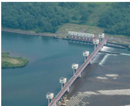
取水施設(岡本頭首工)
