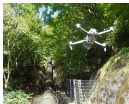
ドローンを使用した保守管理
