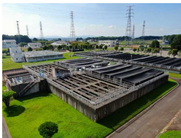
浄水・配水施設(薬品沈澱池・配水池)
