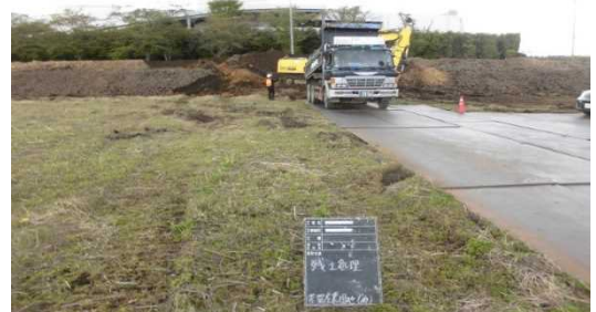
（建設発生土を芳賀第2工業団地に搬入）
