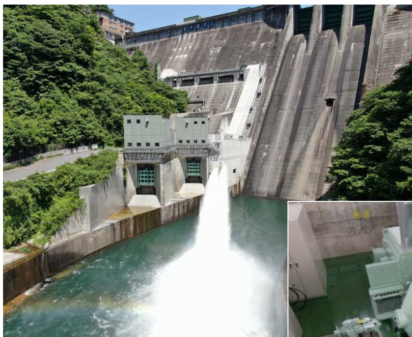
五十里発電所
