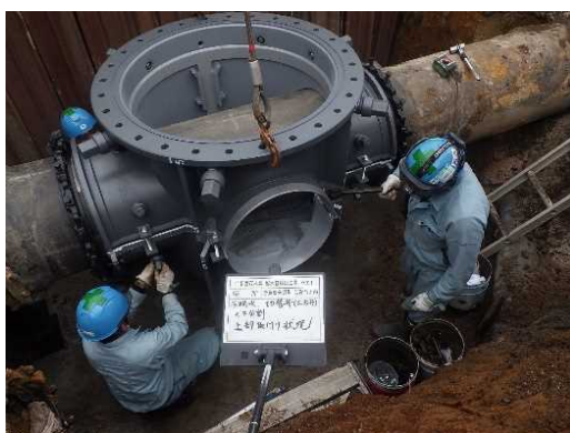
不断水バルブ設置工事
