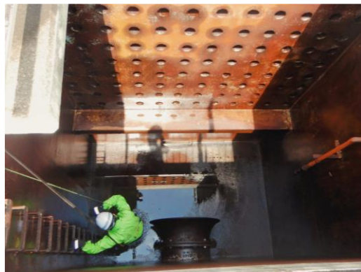
▼ 土木構造物の点検
