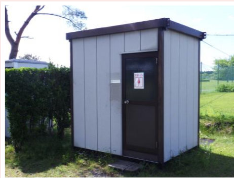
▼ 更新予定のコース内トイレ
