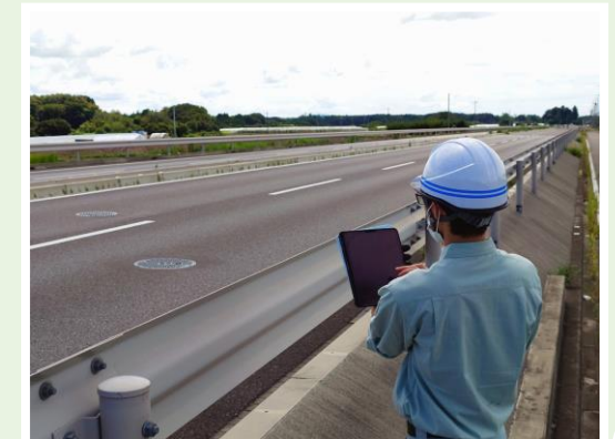
▼ 管路GISを活用した点検
