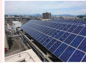
▲ 太陽光発電設備更新
