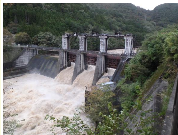
▲ 小網ダム出水状況
