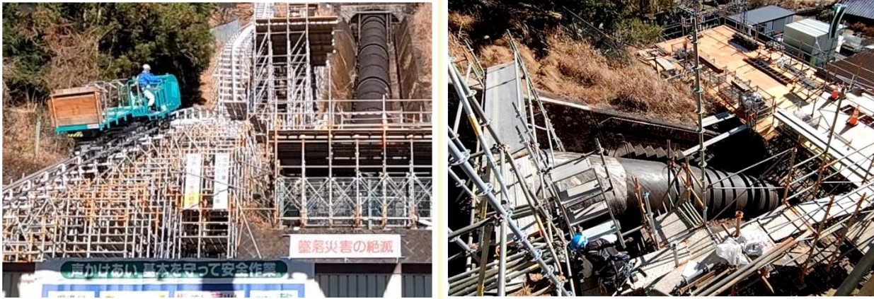
▲ 足尾発電所水圧鉄管耐震補強工事の状況 (R6~7年度実施) ▲
