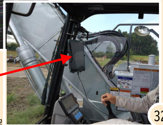
▲ モニターで施工状況を確認
