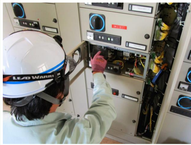
◀ 電気設備の点検
