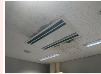
▲ 空調設備更新 (PAC屋内機)
