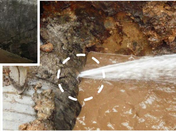
土壤腐食による配水管からの漏水▶
