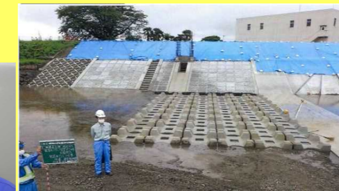
飯田堰の根固めブロック敷設完了時 撮影日：R2.7.9
