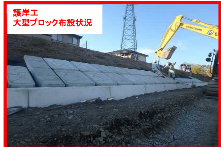
護岸工事その27 株式会社榑下野土木 護岸工:堤防法面を守るためにコンクリートブロックや張芝などを施工します。
