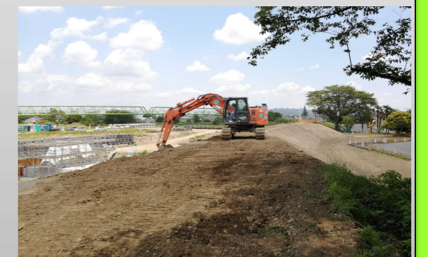
堤防の工事写真
