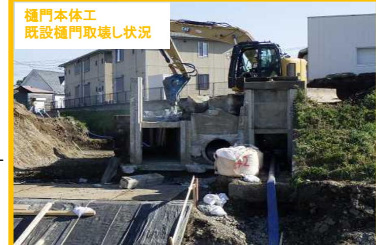
排水樋門改築工事その3 篠崎建設株式会社 樋門本体工(樋門改修工事):新しい計画にともない、樋門の改修工事を行います。
