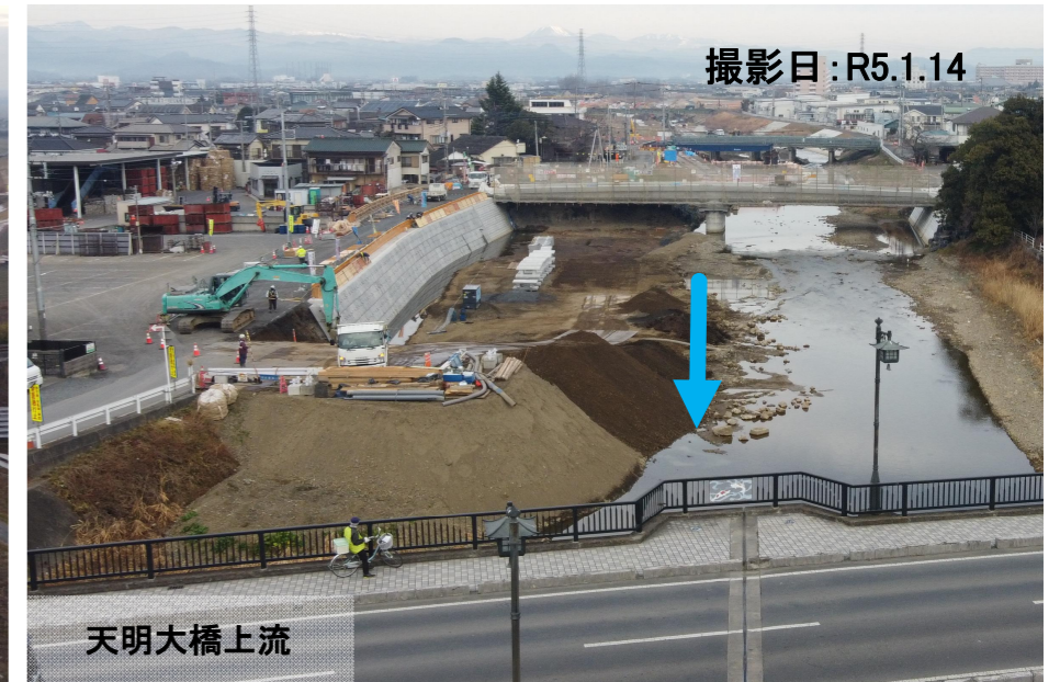
護岸工事その47 朝日建設株 大型連結ブロックを据付しています。
