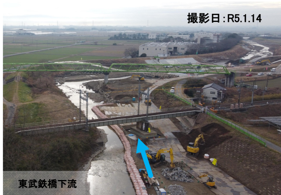
護岸工事その45 (株)下野土木 護岸の基礎ブロックを設置しています。
