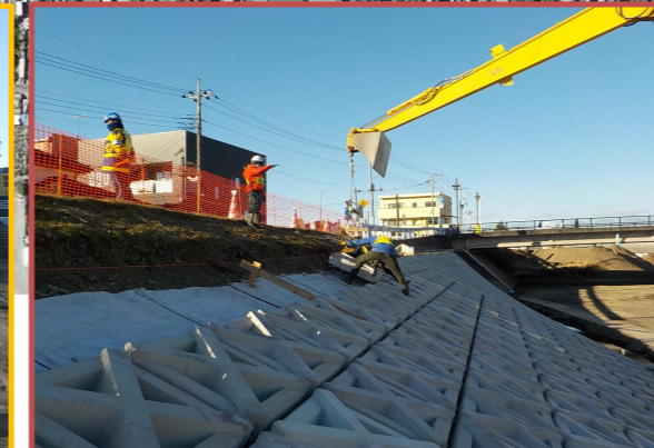
護岸工事その47 朝日建設株 大型連結ブロックを据付しています。
