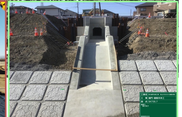
排水樋門改築工事その34 篠崎建設株 樋門のコンクリート打設が完了しました。
