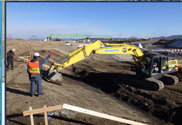
護岸工事その42 榊落合土木 法面整形を行っています。
