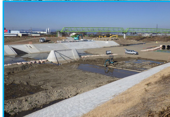
堰上部設置工事その4 日東河川工業株 ゴム袋体の据付を行っています。
