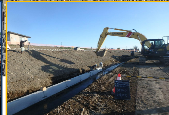
護岸工事その45 (株)下野土木 護岸の基礎ブロックを設置しています。
