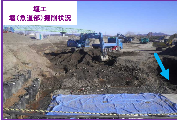
堰下部工設置工事その3 榑東日本土木 堰工:新しい河川計画にともない、農業用取水堰の改修を行います。
