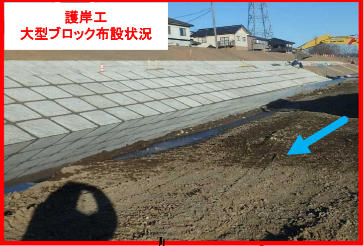
護岸工事その27 榑下野土木 護岸工:堤防法面を守るためにコンクリートブロックや張芝などを施工します。
