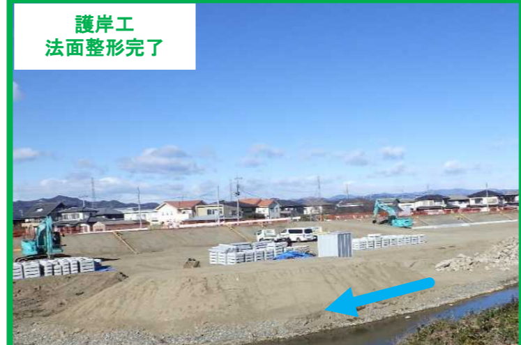
護岸工事その33 榑落合土木 護岸工:堤防法面を守るために護岸ブロック張工や張芝などを施工します。
