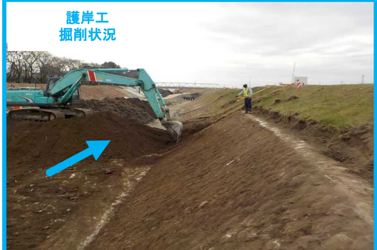
護岸工事秋山川その1 朝日建設 護岸工:堤防法面を守るためにコンクリートブロックや張芝などを施工します。
