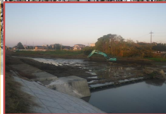
護岸工事その46 須永鉄工建設株式会社 河床の掘削を行っています。
