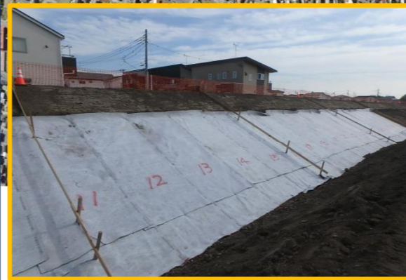
護岸工事その45 (株)下野土木 ブロック張の吸出し防止材を設置しています。
