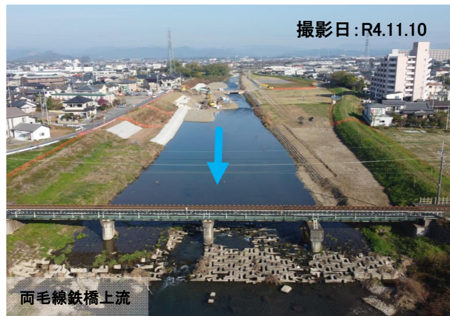
護岸工事その45 (株)下野土木 ブロック張の吸出し防止材を設置しています。
