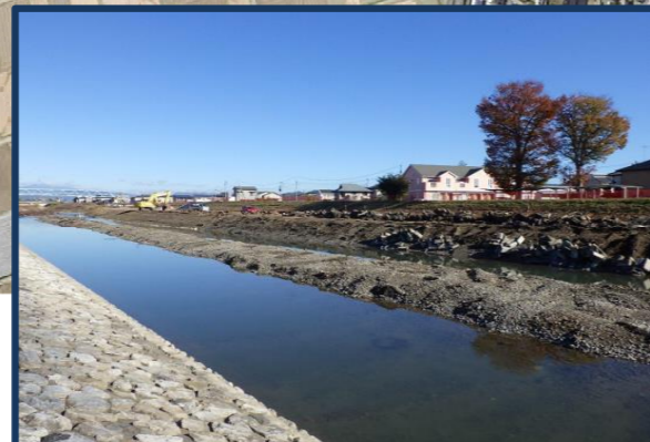
護岸工事その44 (株)東日本土木 既設護岸ブロックの撤去を行っています。
