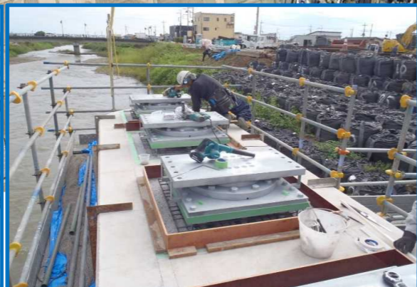
中橋上部工設置工事その6 川田建設(株) 橋桁を受ける支承を据付けています。
