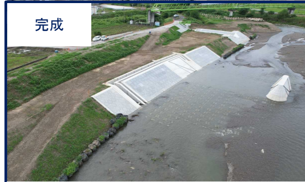
堰下部設置工事その3 (株)東日本土木 工事完成
