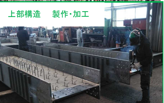
中橋上部工設置工事その6 川田建設(株) 中橋上部構造の工場製作をしています。
