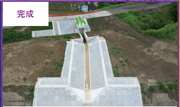
取水樋管設置工事その31 (株)東日本土木 工事完成
