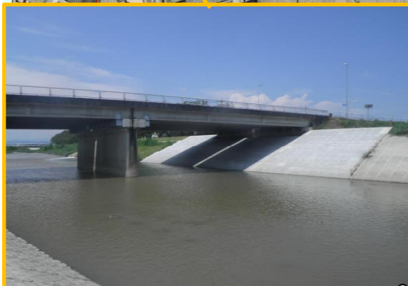
国道50号付近 護岸工事 施工者 篠崎建設株式会社
