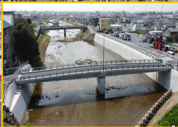
中橋架け替え工事 施工者 山菊・朝日・篠崎JV、川田建設株式会社
