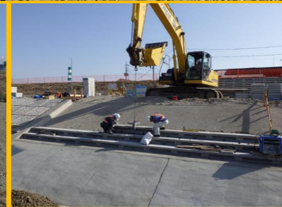
護岸工事その44 (株)東日本土木 階段ブロックを設置しています。
