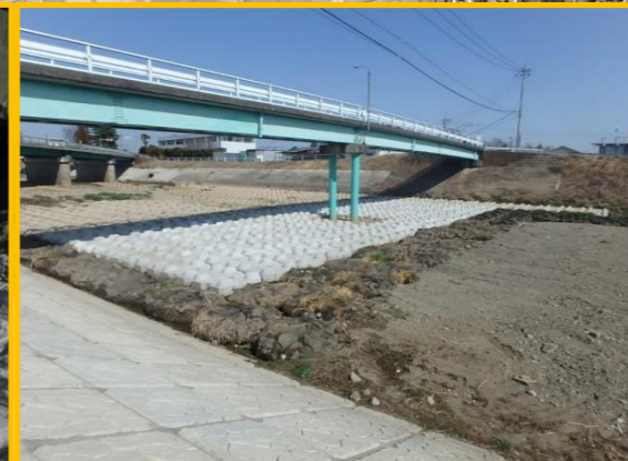
護岸工事その43 (榑下野土木) 根固めブロックの設置が完了しました。
