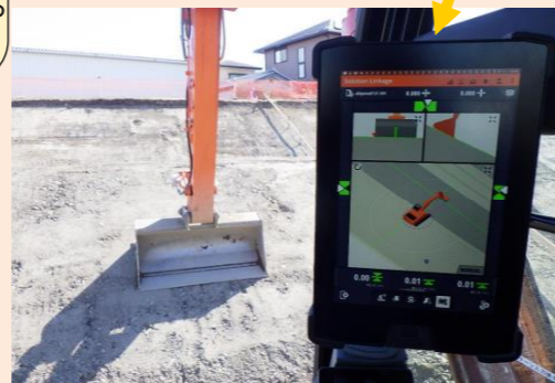
重機の中にはモニターが取り付けられており、モニターに表示された設計データ(どこを掘るか示すもの)を確認しながら、掘削作業を行っています。
