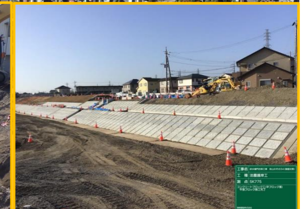
排水樋門改築工事その34 篠崎建設株式会社 平張ブロックの設置が完了しました。
