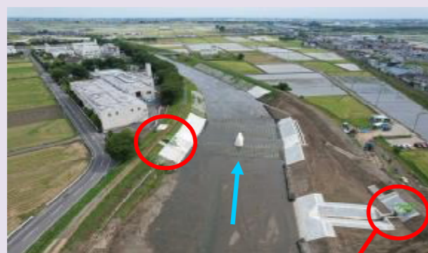
統合堰周辺の取水樋門
