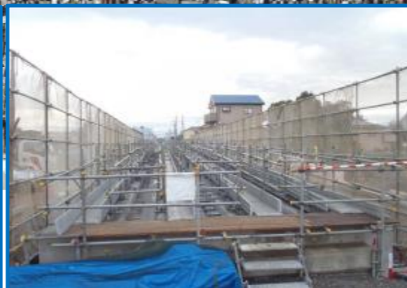
中橋上部工設置工事その6 川田建設(株) 橋桁を施工するための足場を設置しています。
