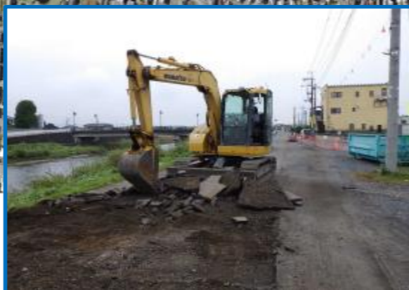
中橋下部工設置工事その5 山菊・朝日・篠崎特定JV 引堤箇所の既設舗装版撤去を行っています。
