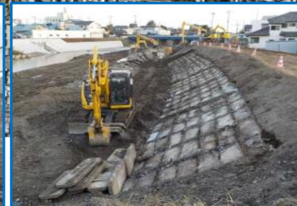
護岸工事その4 朝日建設(株) 引き堤に伴い、既設護岸の撤去を行っています。
