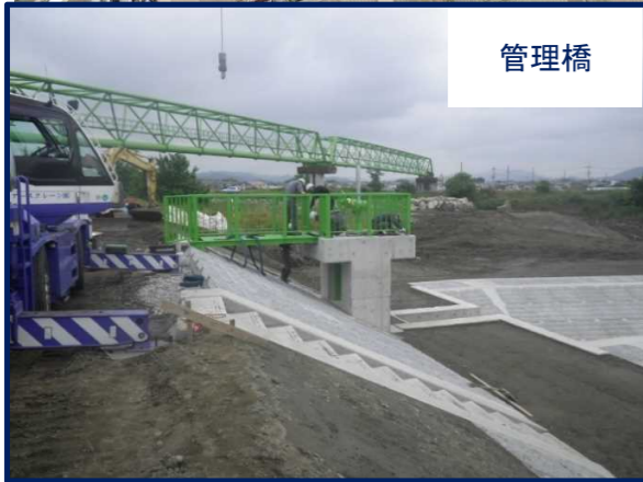
取水樋門設置工事秋山川その31(株)東日本土木樋門の管理橋及び転落防止柵を設置しています。
