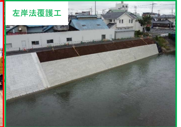
護岸工事秋山川その4 朝日建設(株)大橋上流左岸にコンクリートブロック積みを実施しました。
