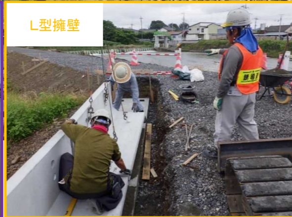
護岸工事その33 (株)落合土木堤防高の変更に伴い、市道取付部にL型擁壁を設置しています。
