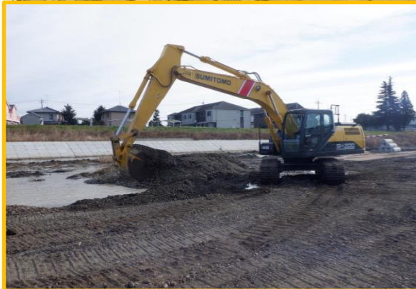
護岸工事その51 株式会社下野土木 仮設道路の整備を行っています。
