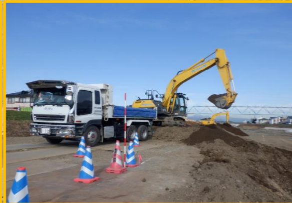
護岸工事その52 株式会社落合土木 現場内の土砂を場外に搬出しています。
