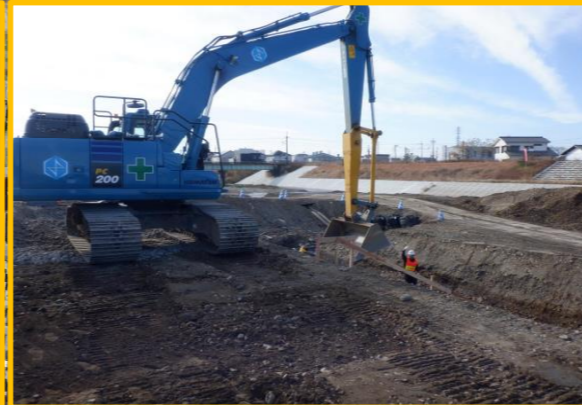
護岸工事その53 株式会社東日本土木 低水護岸部に砕石を敷均しています。
