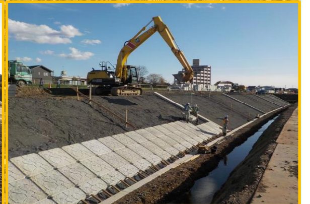
護岸工事その56 朝日建設株式会社 低水護岸部のブロックを据付しています。
