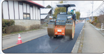
舗装修繕工事(施工中)
