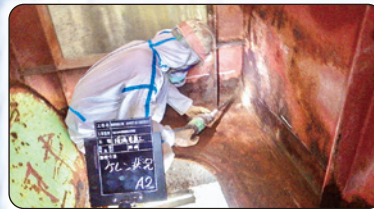
【橋梁補修の作業状況】
