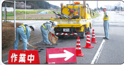
応急舗装修繕作業
