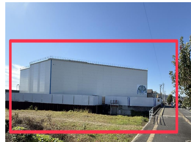
発進立坑(流出立坑)
