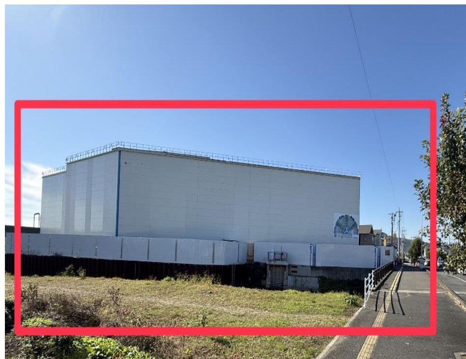
発進立坑(流出立坑)
