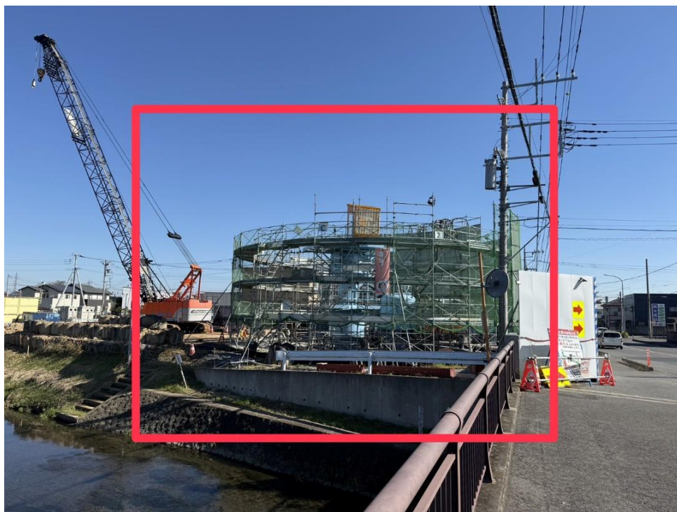
到達立坑(流入立坑)
