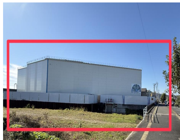
発進立坑(流出立坑)
