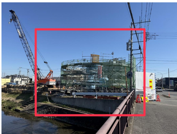
到達立坑(流入立坑)
