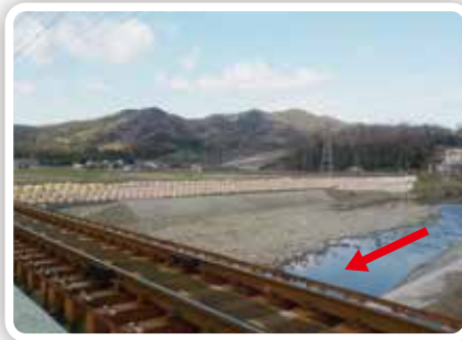
応急仮工完了
