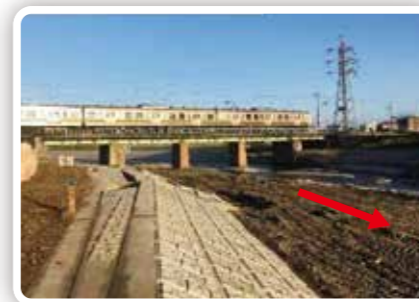
■JR両毛線橋梁(架替)
