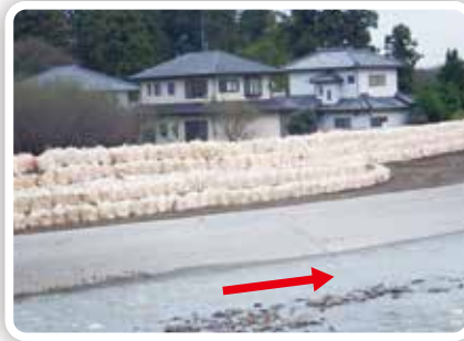
応急仮工完了
