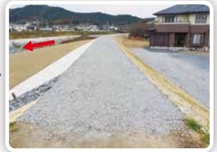
応急工事完了
