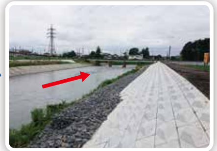
応急工事完了
