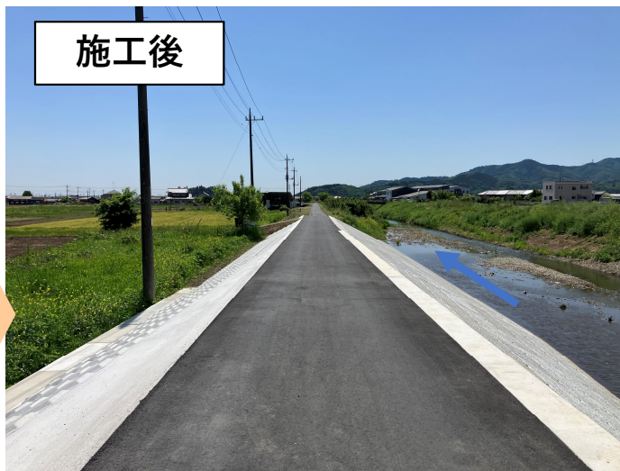
巻堤工を実施
