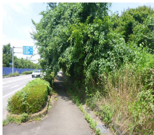
(樹木で覆われた歩道)
