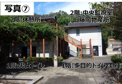
写真⑦東側 2階：中央監視室 旧藤岡物産所 2階：休憩所 1階：男女トイレ 1階：多目的トイレ・倉庫
