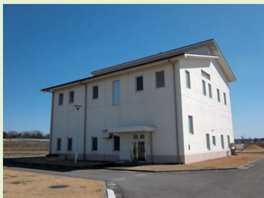
ポンプ棟・汚泥棟
