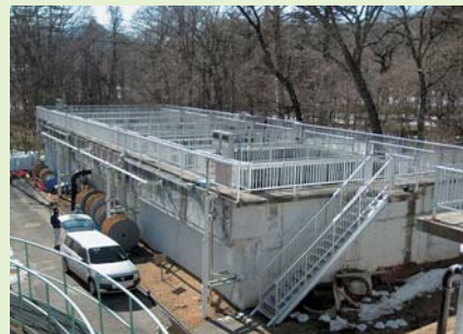
エアレーションタンク
