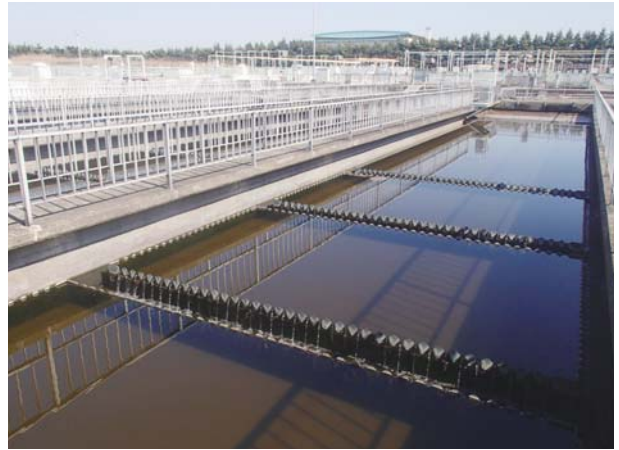
小山水処理センター最終沈殿池
