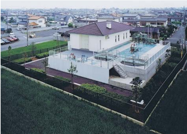
坂西団地水処理センター全景①
