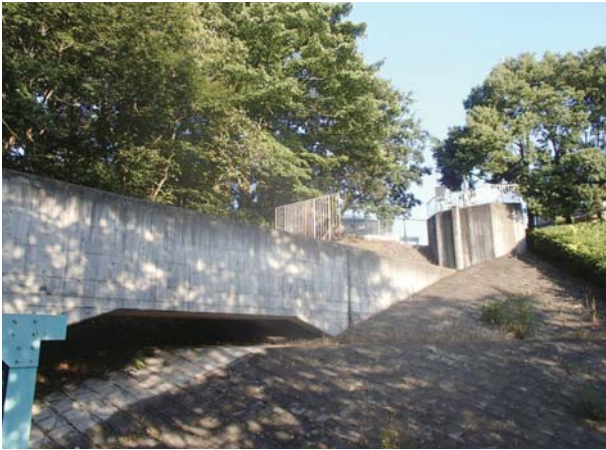
小山水処理センター流入渠
