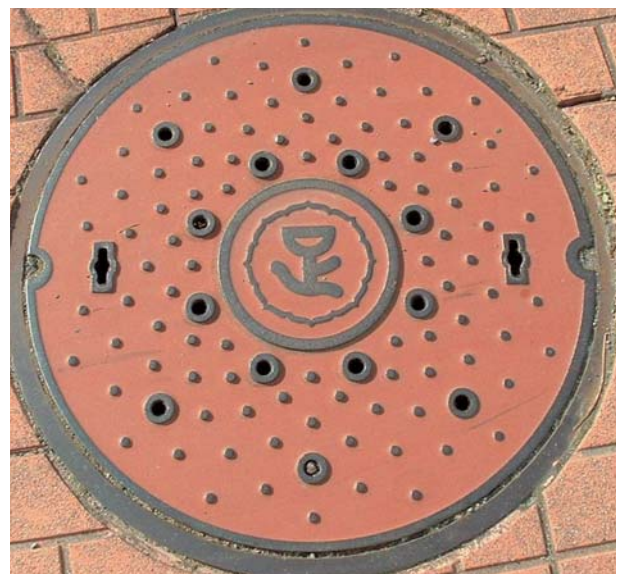
マンホール④
