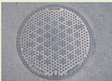
マンホール①
