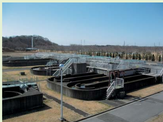
オキシレーションディッチ
