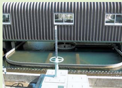
最終沈殿池②
