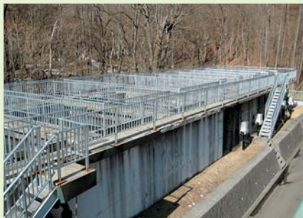
インホフタンク
