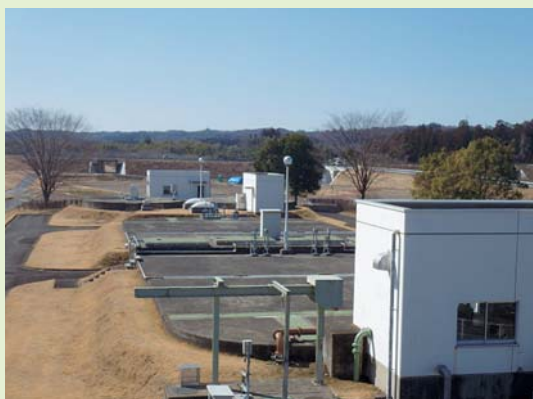
オキシレーションディッチ
