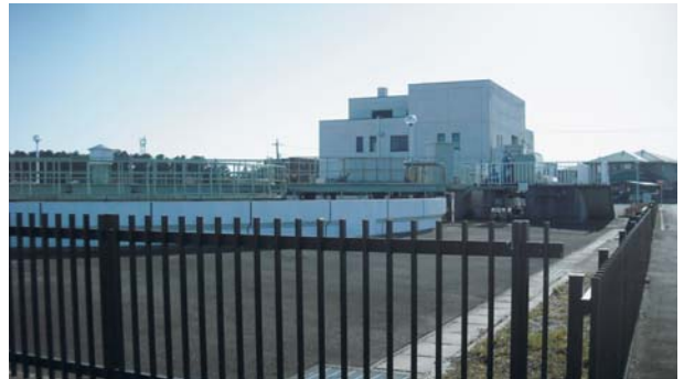
仁井田水処理センター全景
