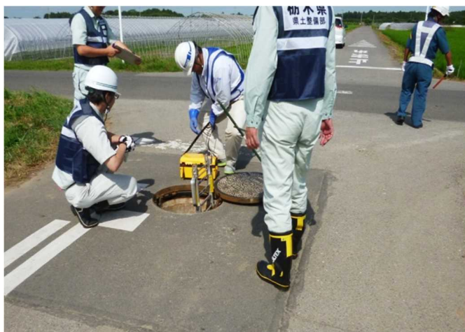
写真：下水道BCP合同訓練（右：説明会 左：マンホールによる応急対応）
