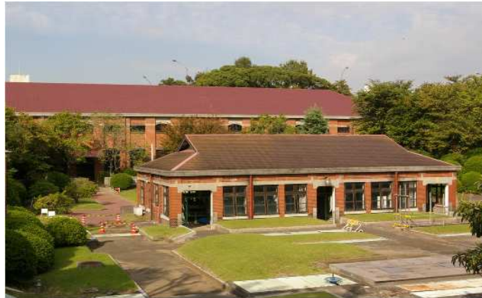
東京都三河島汚水処理場 (我が国最初の下水処理場:大正11年)
