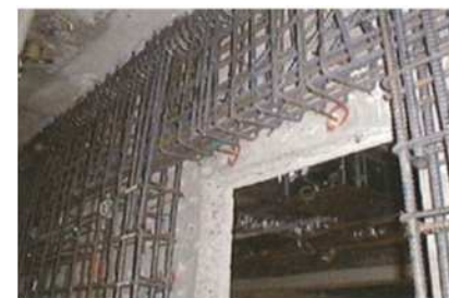
躯体補強による処理場の耐震対策
