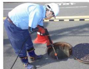
高圧水による洗浄状況
