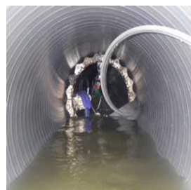
管更生による管渠の耐震対策
