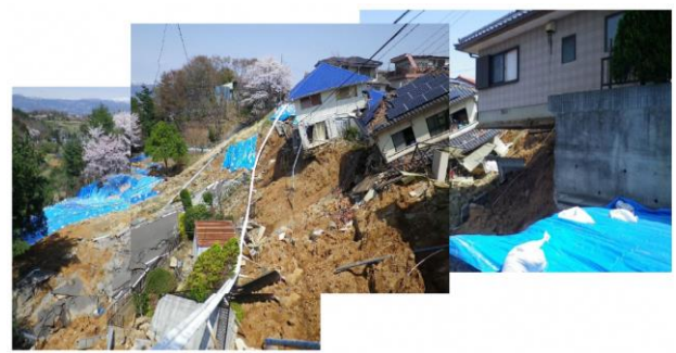
(d)液状化による側方流動
