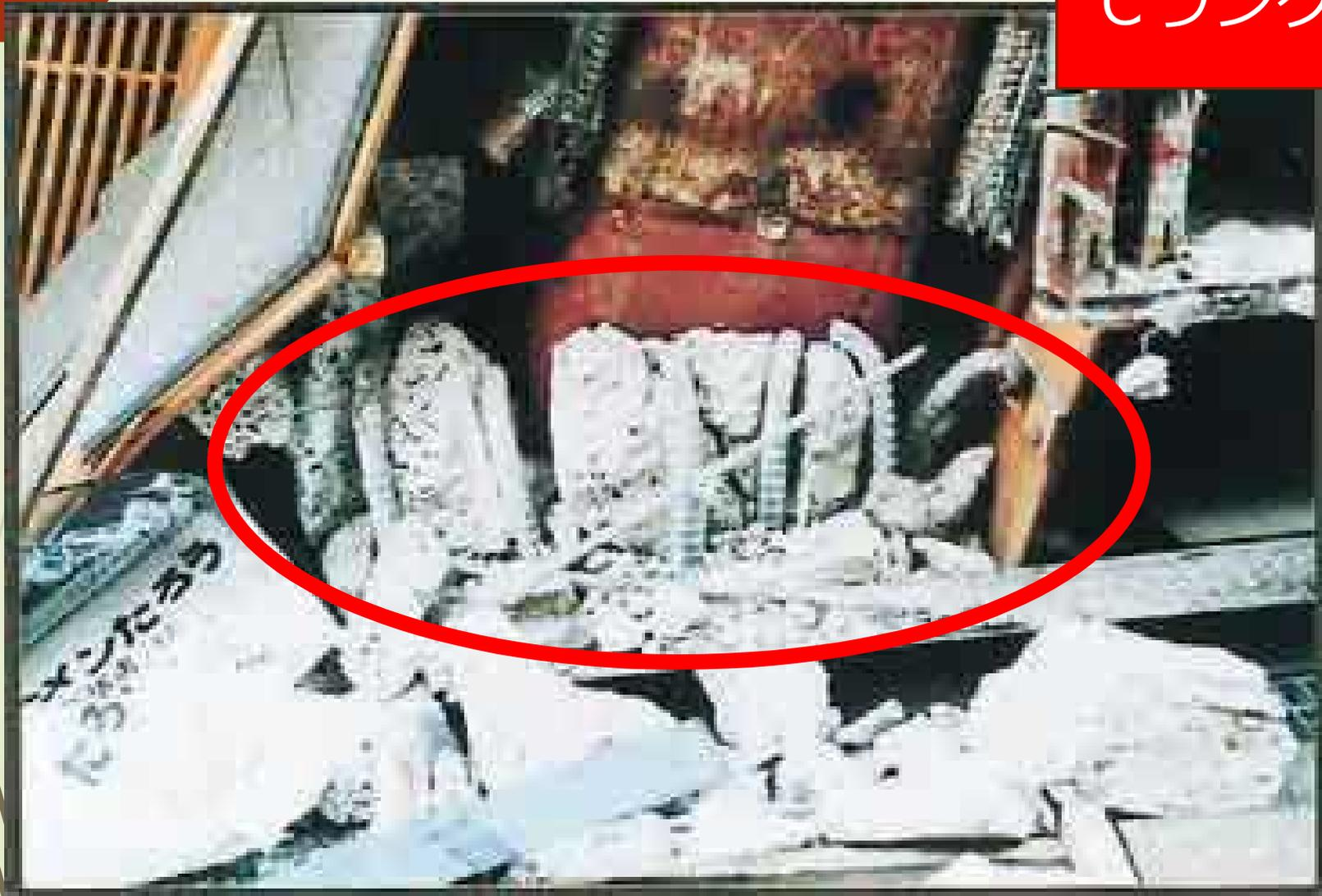
写真-20 根巻き高さが十分でない根巻き柱脚の移動
