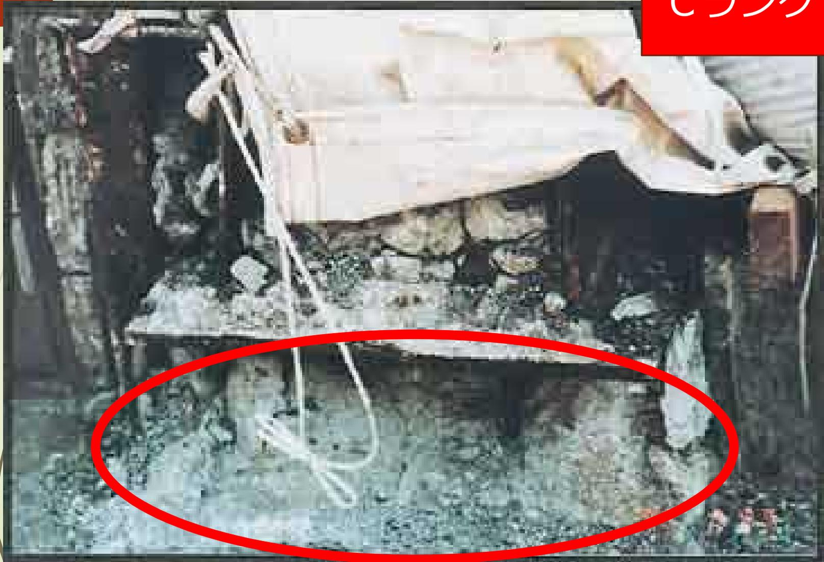
写真-21 軸力支持能力を失った柱脚ベースプレート下部コンクリート
