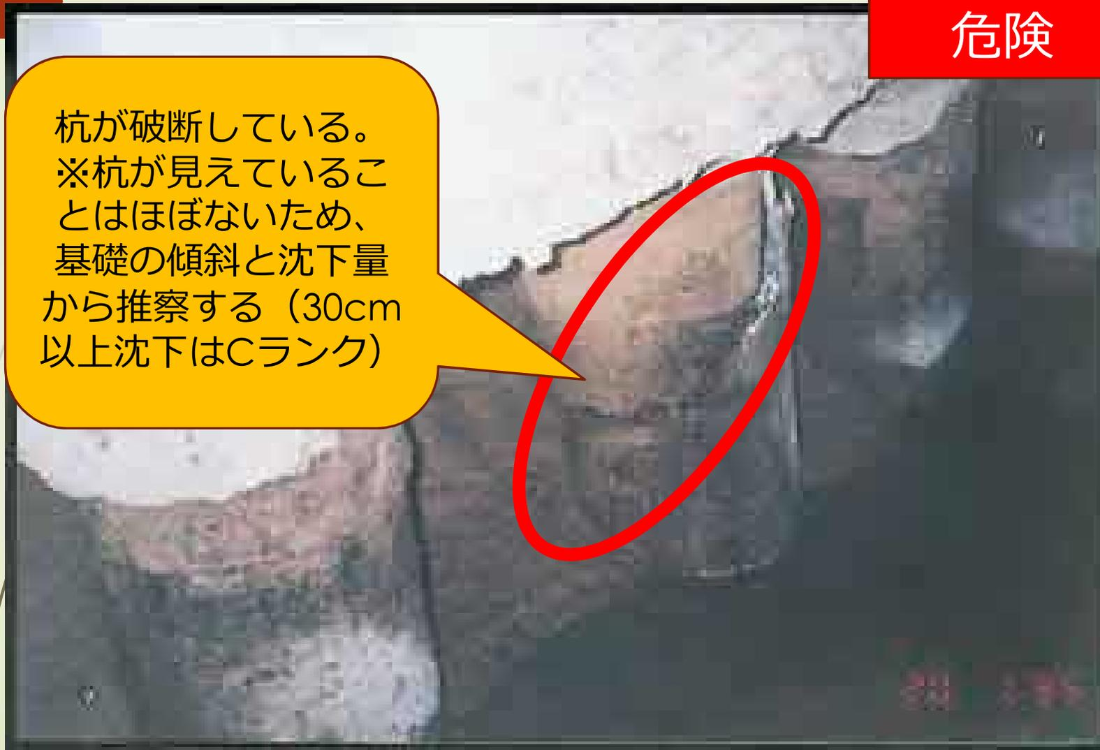
写真－5 杭の著しい破損
