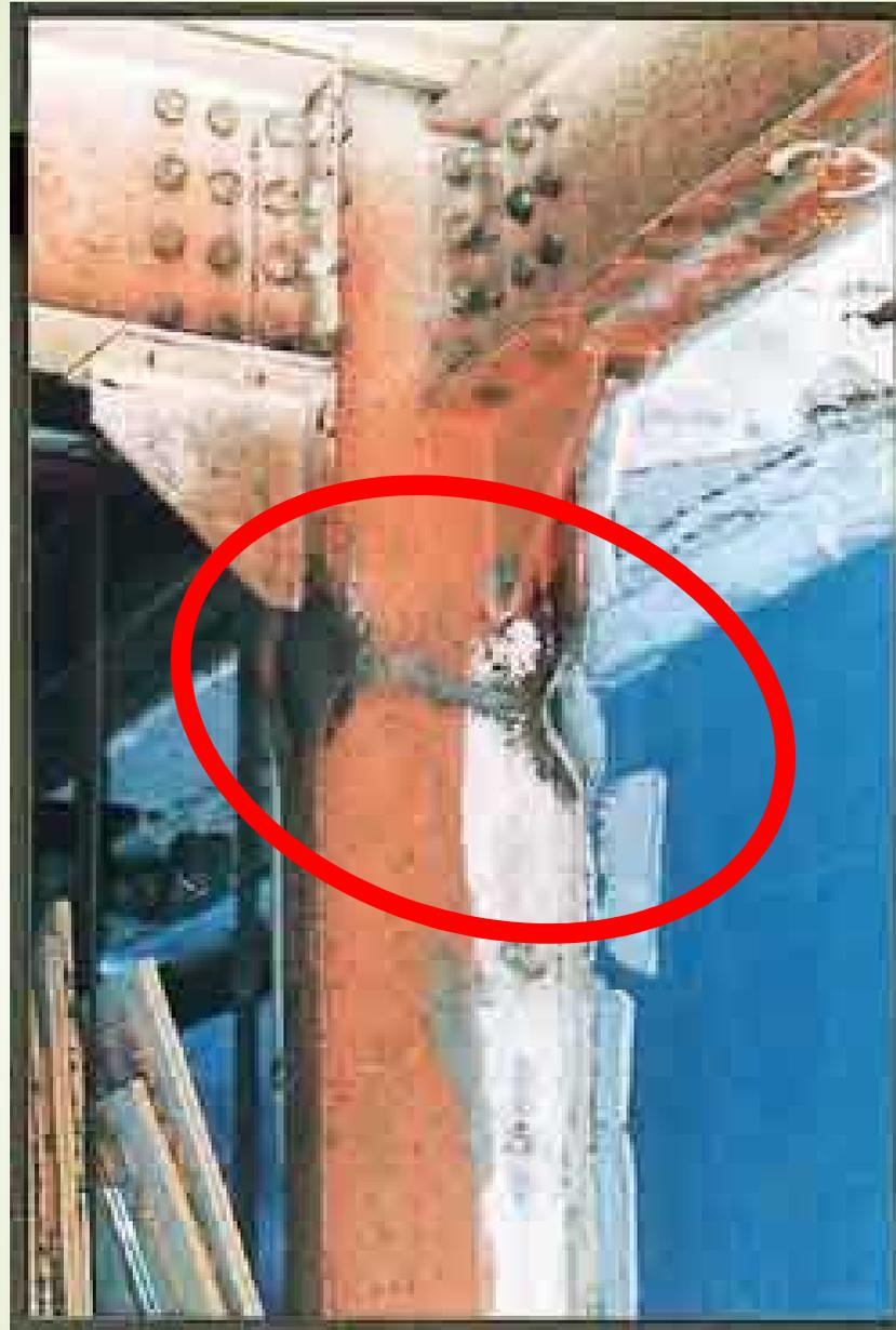
写真-13 局部座屈を生じた柱
