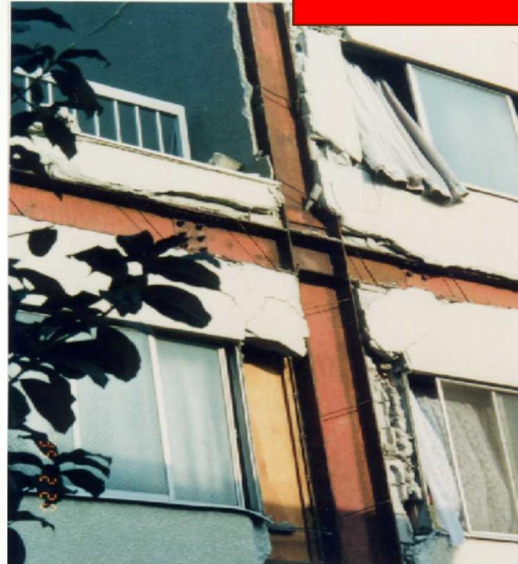
写真-23 落下危険物Cランクの例
