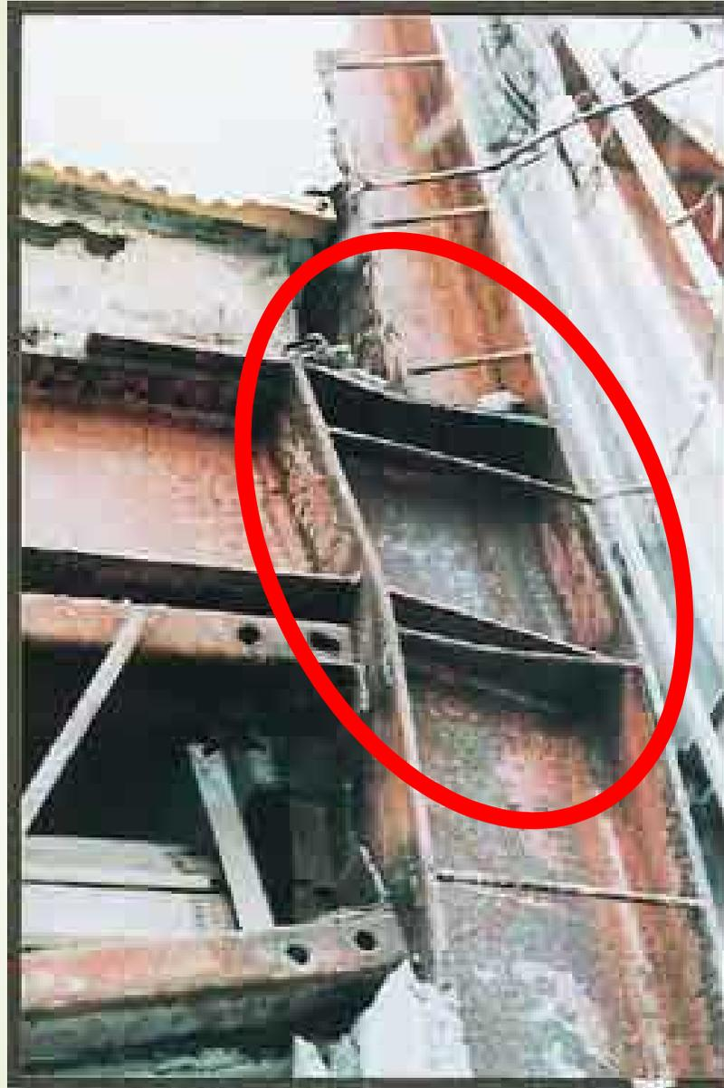
写真-14 著しく腐食した柱材の局部座屈
