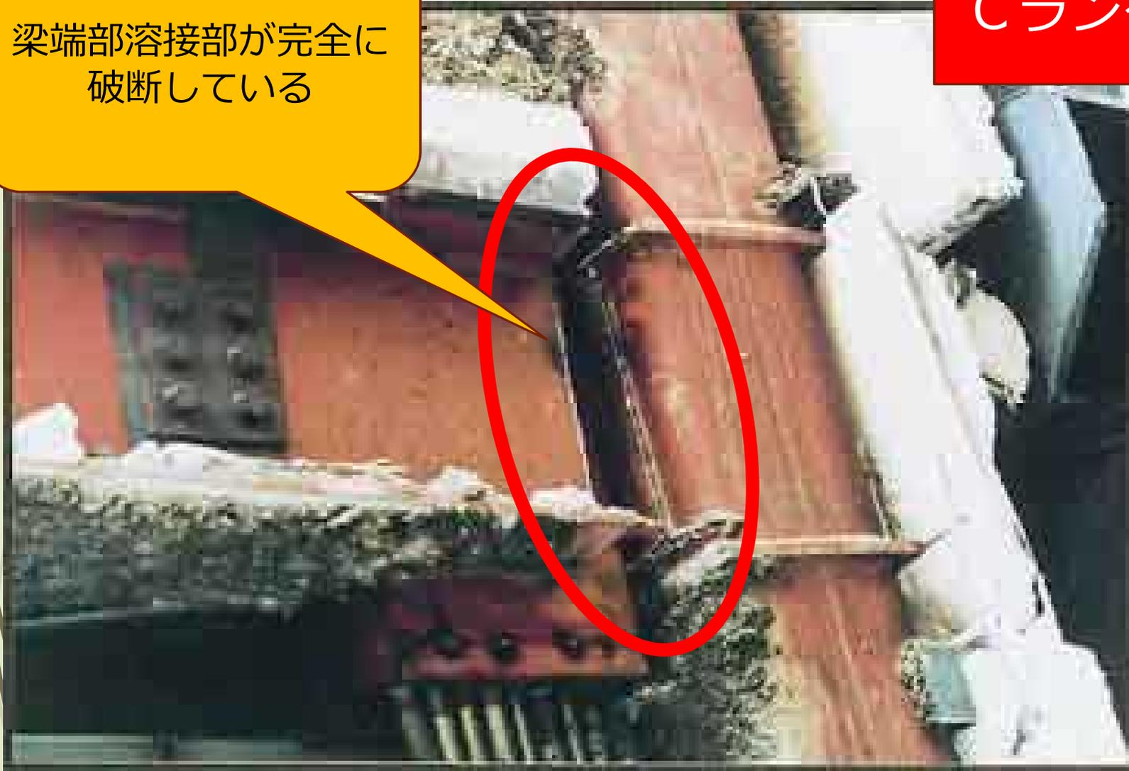
写真-18 梁端部溶接部の破断
