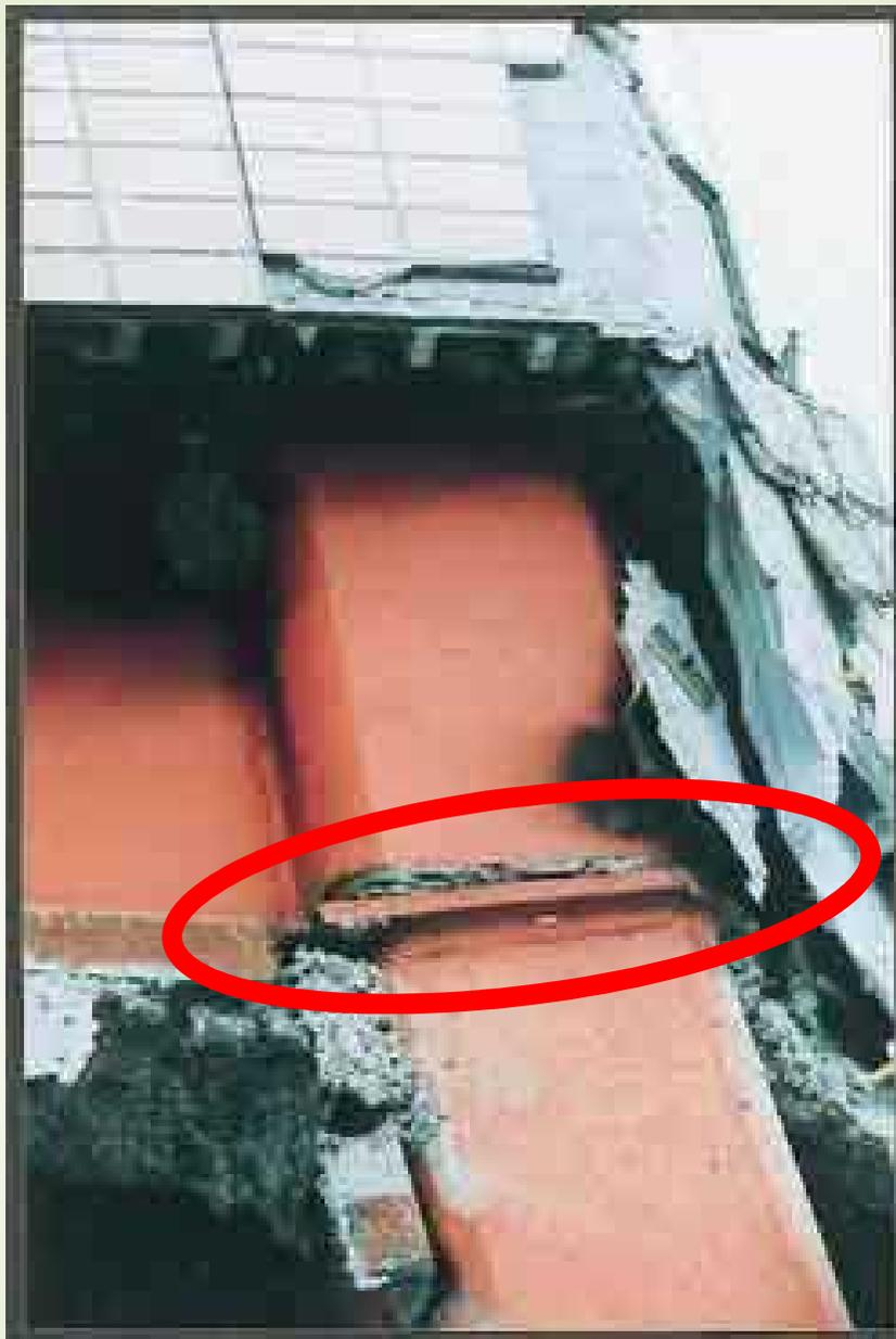
写真-19 柱と通しダイアフラムとの溶接部の破断
