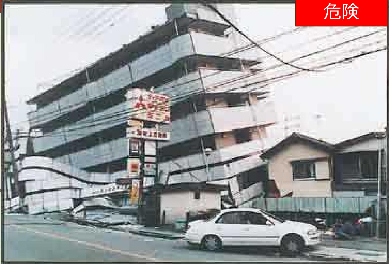
写真－3 低層階で落階した建築物
