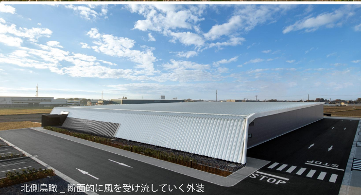
東武伊勢崎線の県駅ホームから建物をみる。北からの卓越風（赤城おろし）を受け流す、斜めの外壁から屋根面にシームレスに繋がるこの外観デザインは、建築主のシンボルとなるだけでなく、地域のシンボル・ランドマークとなっている。
