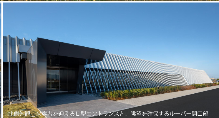
東武伊勢崎線の県駅ホームから建物をみる。北からの卓越風（赤城おろし）を受け流す、斜めの外壁から屋根面にシームレスに繋がるこの外観デザインは、建築主のシンボルとなるだけでなく、地域のシンボル・ランドマークとなっている。
