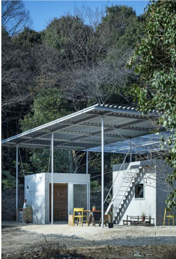
入口側のニワ。敷地入口に向かって開いた軒先空間。
