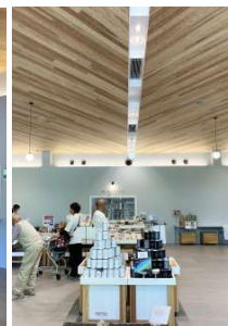
天井ライン ラインには空調、照明等をまとめて配置している。
