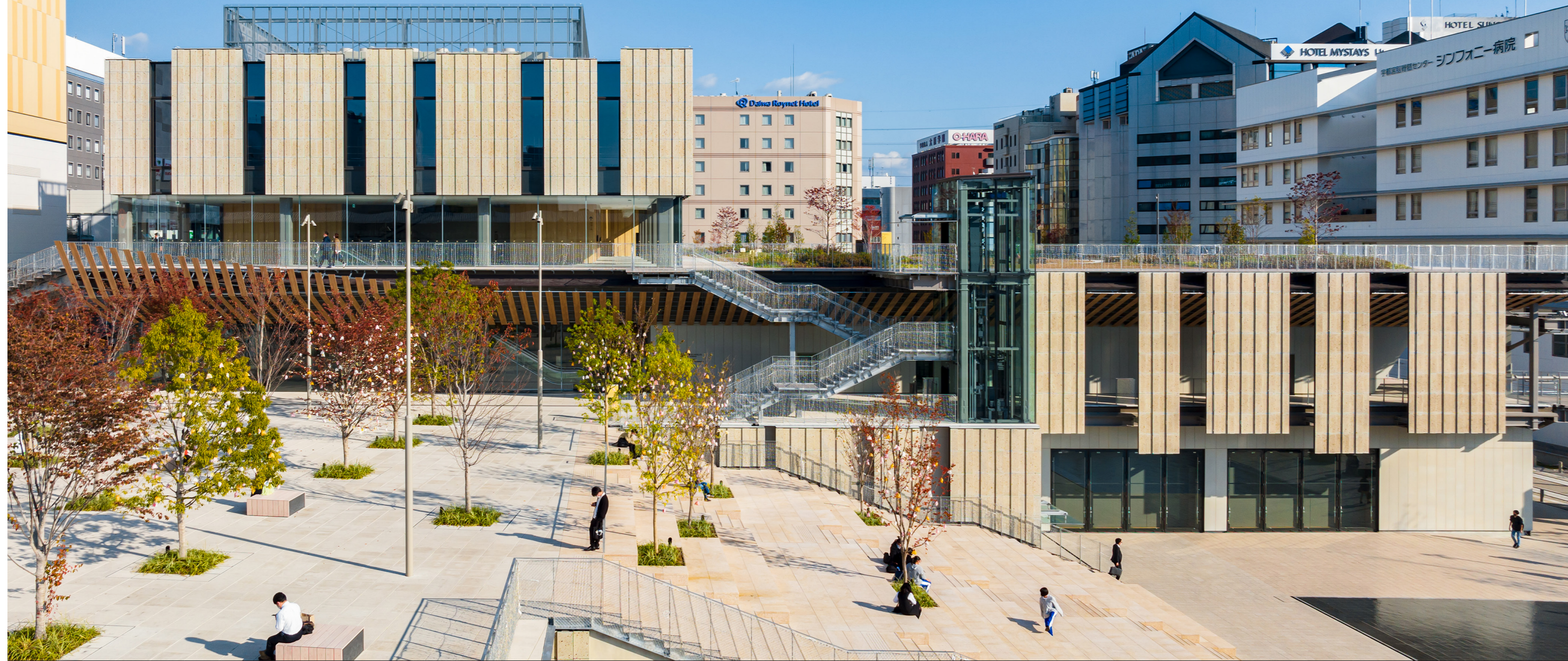
JR 宇都宮駅から全景を望む。芳賀・宇都宮LRTの起点でもある
