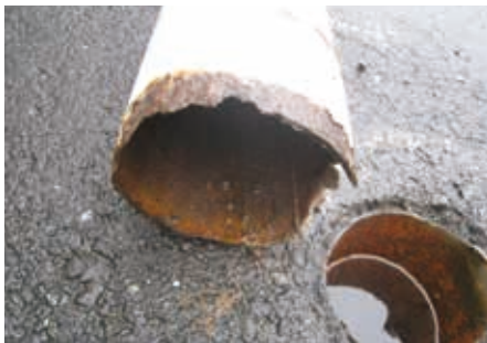
ポール看板の倒壊
