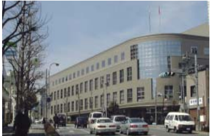
大規模な壁面に対し、窓の配置を工夫し、壁面を分割するなどにより圧迫感を緩和し、街並みのアクセントを形成している。(宇都宮市)
