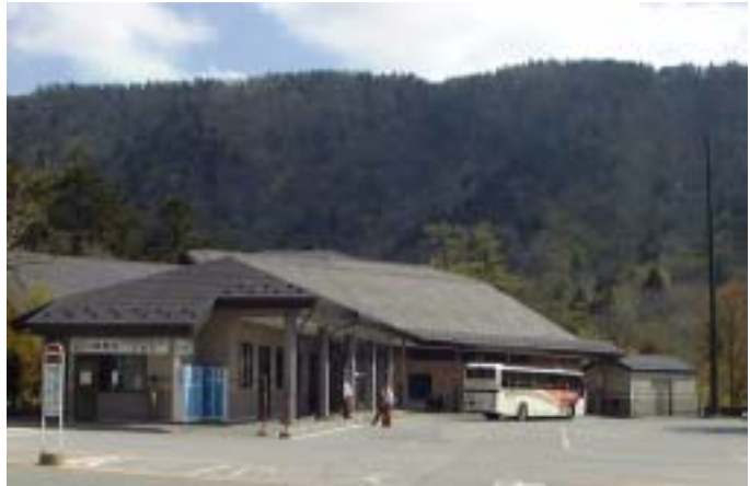
背後の山への稜線を分断しないよう、なるべく低く建築し、緑に囲まれた景観との調和を保っている。(日光市)
