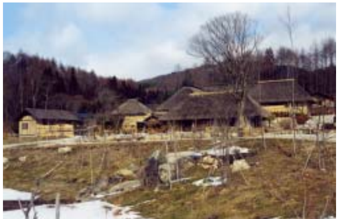
敷地内に残る古くからの庭木を保全して、施設群におけるアイストッとして利用している。(遠野市)
