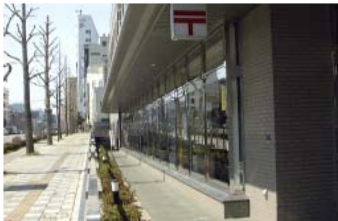
建築物の低層部を、広くガラス張りの開口部とすることで、歩行者空間に対する圧迫感を和らげている。(宇都宮市)
