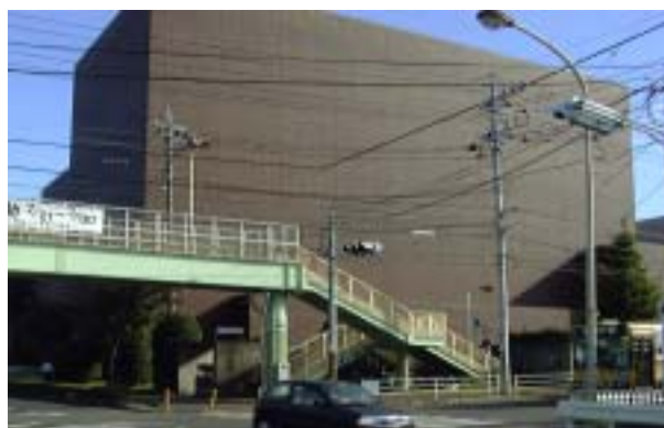
前面道路に対し、開口部のない大きな壁面を向け、見る者に対して圧迫感を与えている。(他県事例)
