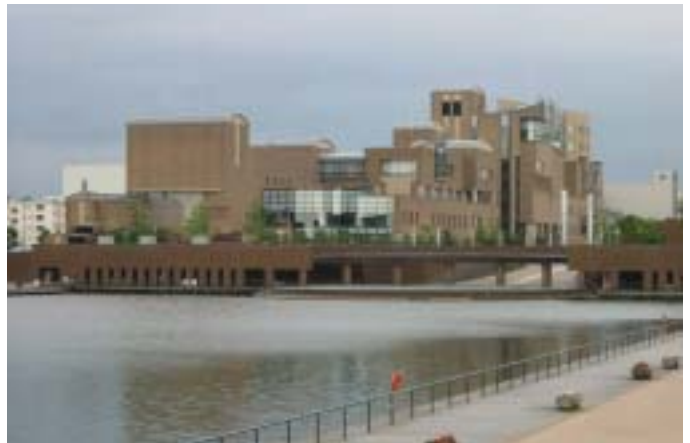
まとまりある建築物の規模、配置とすることにより、水辺の広がりと調和している。(富山市)
