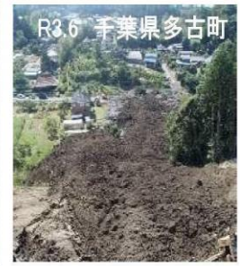
廃棄された土石の崩落 軽傷者1名、県道通行止め
