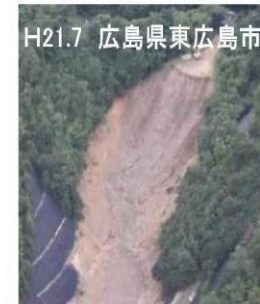
廃棄された土石の崩落 死者1名、重傷者1名、住宅被害1棟
